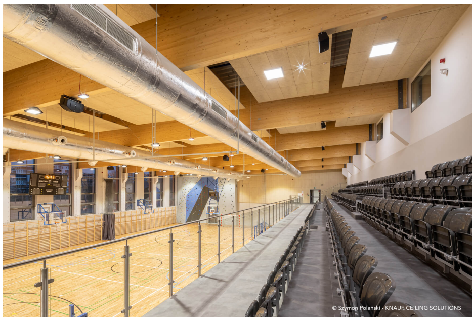
2. Zespół Szkół nr 13, Lublin, WEŁNA DRZEWNA Heradesign Superfine 25 mm Nature 13 AK-01
